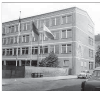
Abb. 60 Südostseite des Neuen Schulhauses (1959)
