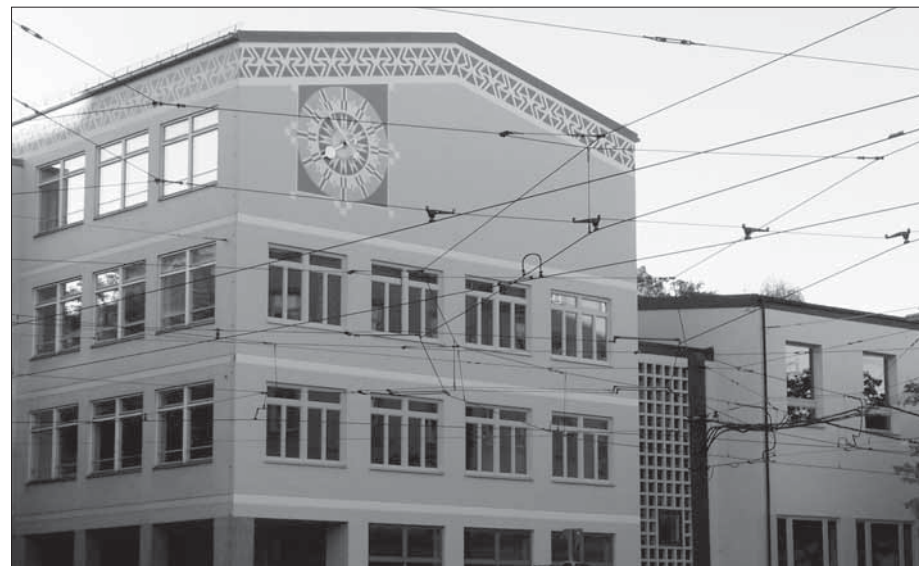
Abb. 89 Renovierte Schulfassade Milchstraße (2008)
